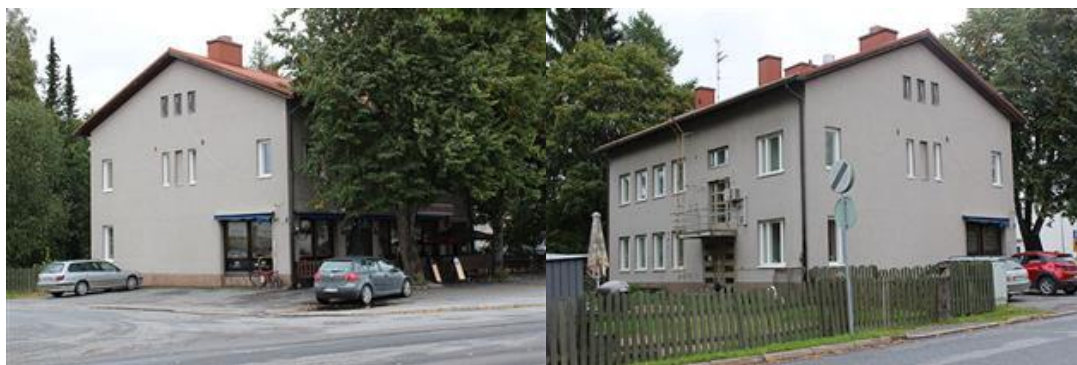
KUVAT: Entisen KOPin rakennuksen julkisivua
