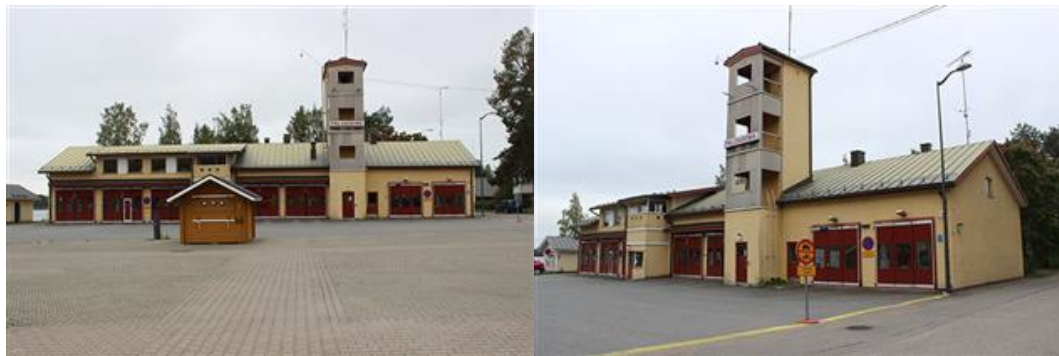
KUVAT: Paloaseman julkisivuja
